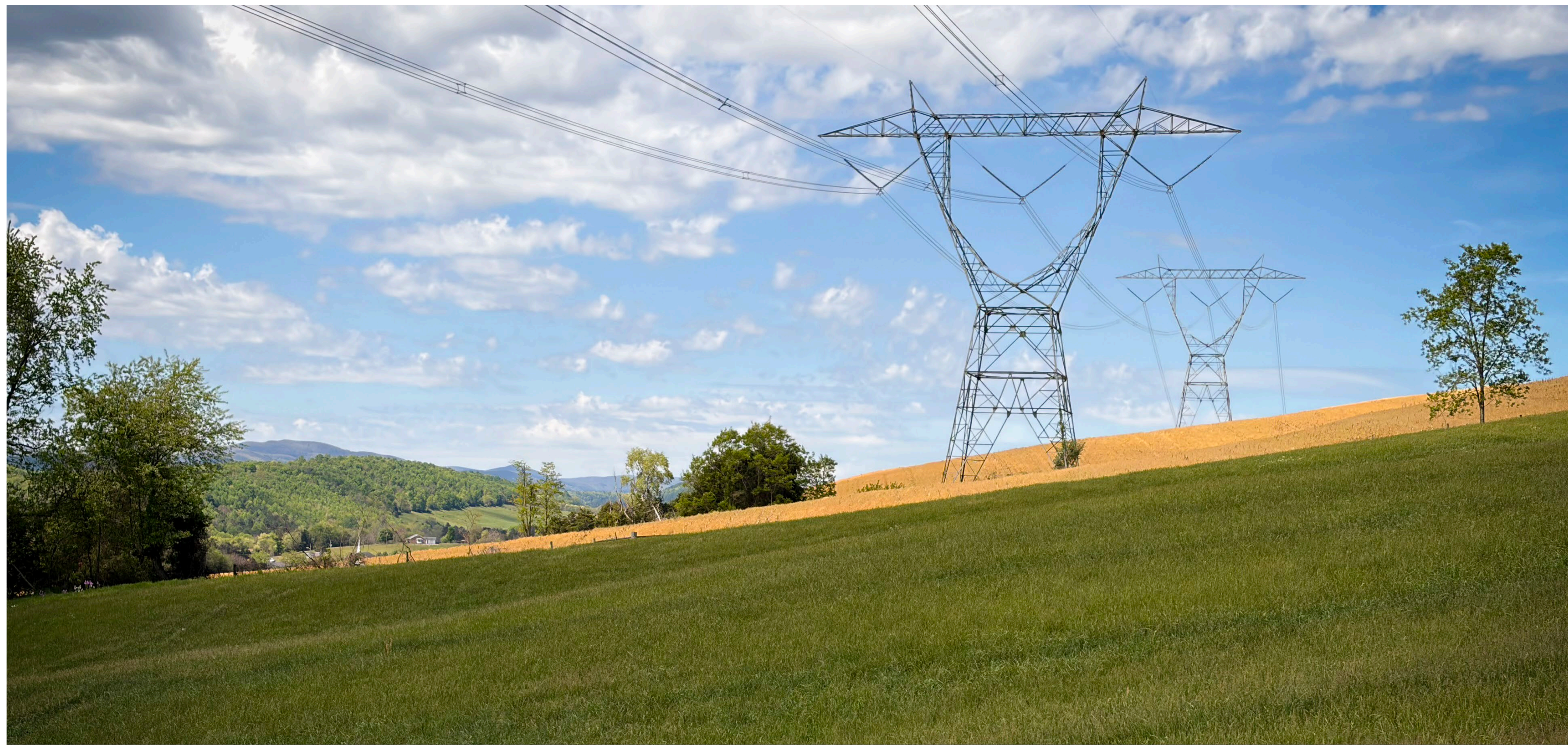
Structure heights are planned to support modern harvesting equipment. La altura de las estructuras se planifica para soportar equipos modernos de cosecha.
