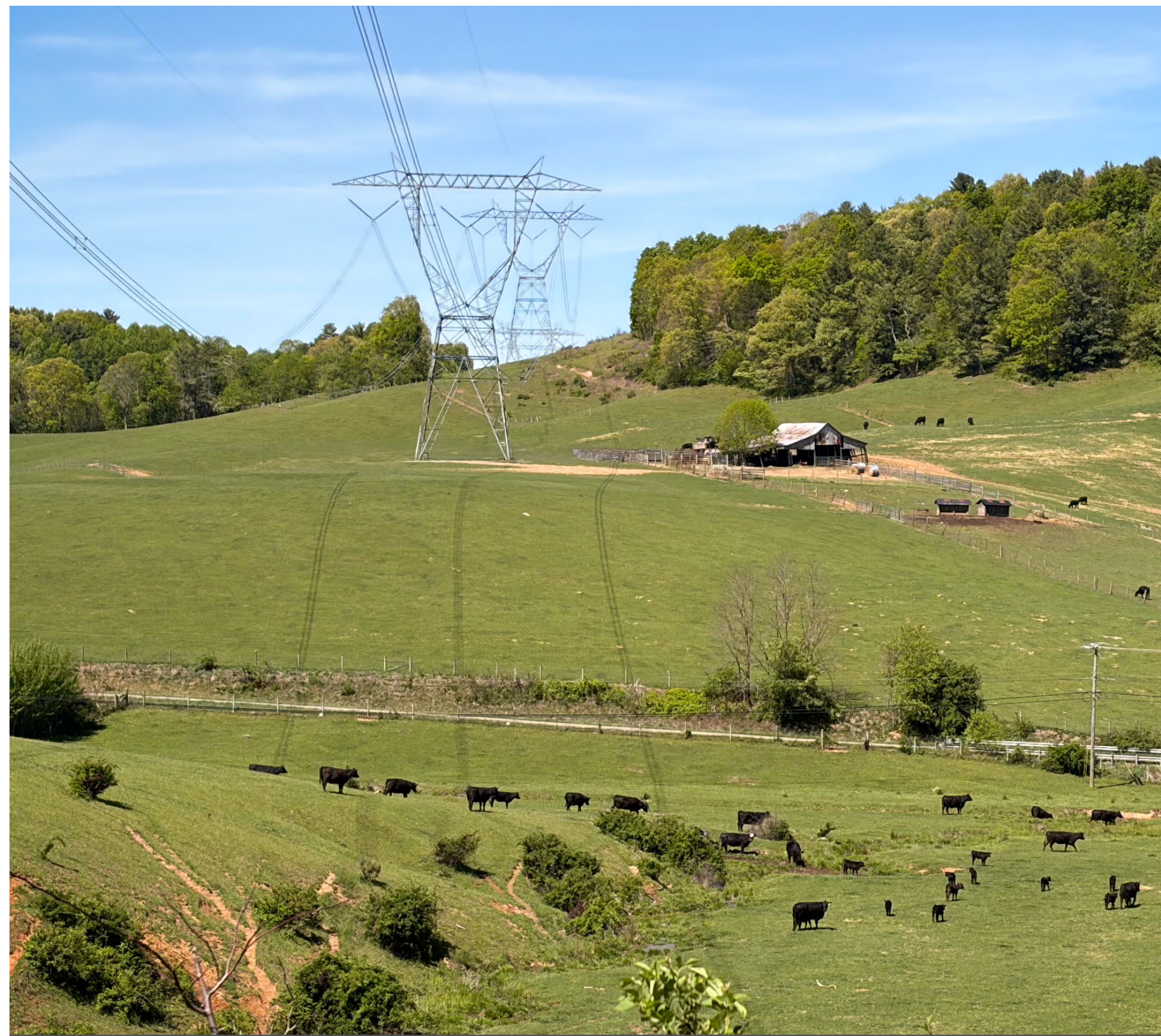
Easement widths vary depending on terrain, structure type and voltage requirements. El ancho de las servidumbres varía según el terreno, el tipo de estructura y los requisitos de voltaje.
