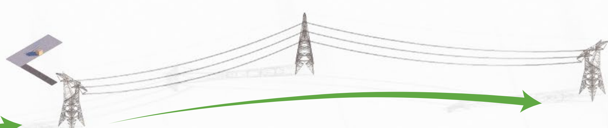
765kV Transmission Line Línea de transmisión de 765 kV
